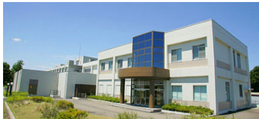
高エネルギー医学研究センター外観
