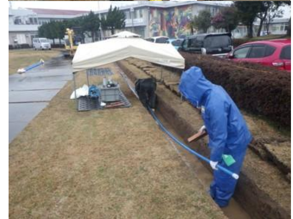
(二の宮・ハツ島)附属学校 屋外給排水・ガス管工事 1億2,100万円
