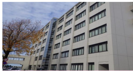
(松岡)看護学科棟屋根防水・外壁改修 4,000万円
