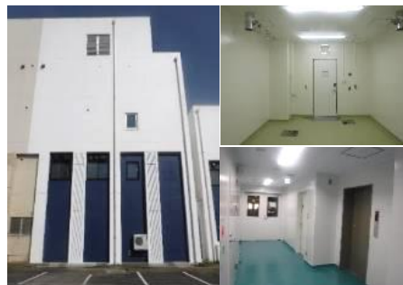
(松岡) 生物資源棟Ⅱ改修 2.7億円
