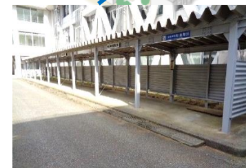
(文京) 駐輪場屋根等改修 200万円
