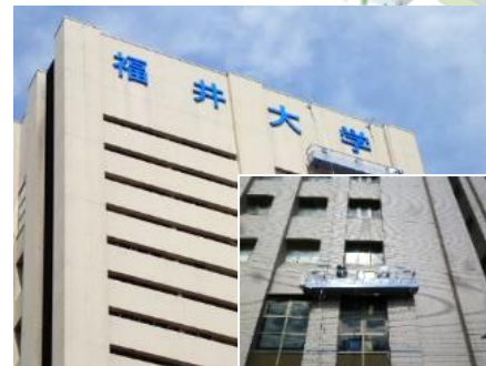
総合研究棟Ⅰ(西) 外壁改修 0.5億円
