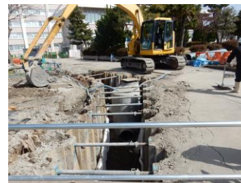
(文京) 屋外給排水配管改修 1.9億円
