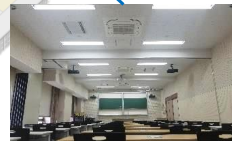
西1階講義室照明・空調改修 0.13億円
