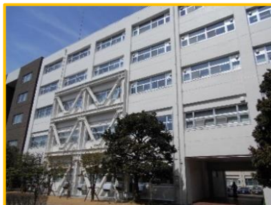
(松岡) 総合研究棟改修I(臨床系)
