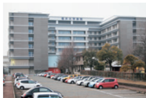
建設中の新病棟
